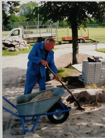
Viel Sand und Steine wurden beim Wegebau bewegt
