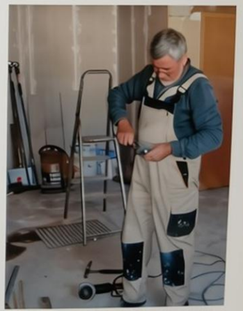
Hans-Jürgen Schley beim Bau des Vereinszimmers
