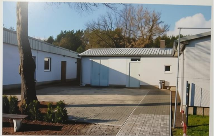
Umfangreiche Pflasterarbeiten vor den Umkleide- und Geräteraumen
